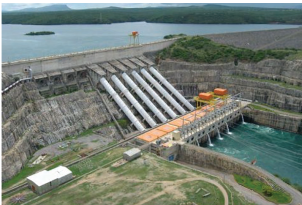
Figura 9 – Usina hidrelétrica. Foto: Anna Paola Bubel / Banco de Imagens da ANA.
