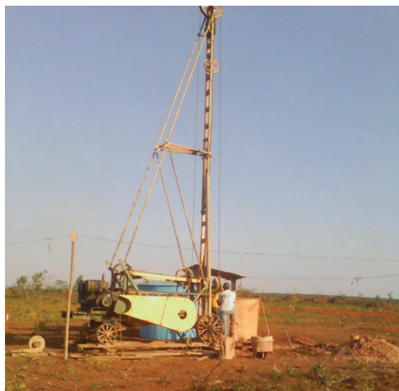
Figura 6 – Equipamento para perfuração de poço. Foto: Fabrício Bueno / Banco de Imagens da ANA.
